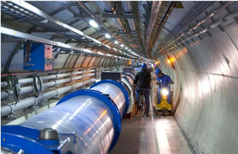
Des milliers d'aimants pour guider les protons dans un tunnel circulaire
